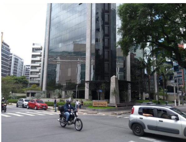
Vista Externa do Imóvel Avaliando - Alameda Vicente Pinzon.
