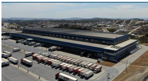
Ribeirão das Neves – Galpão Refrigerado
