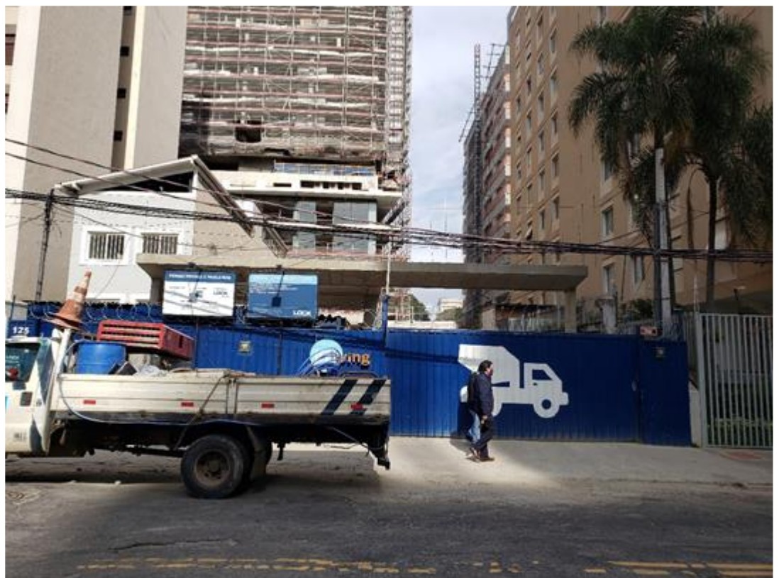
ACESSO PELA RUA HENRIQUE MONTEIRO
