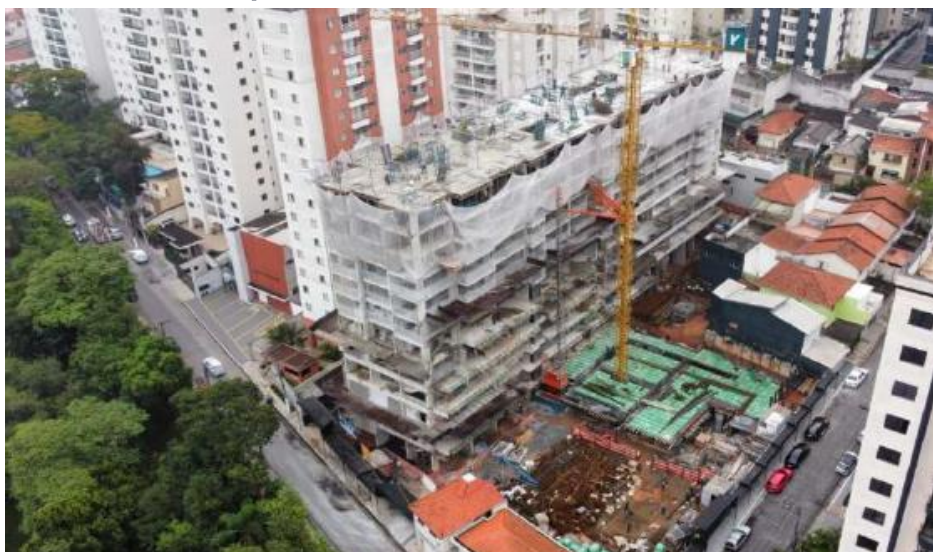
Foto Vista Geral Obra
