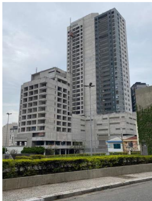
Foto Estrutura da Obra - Misce
