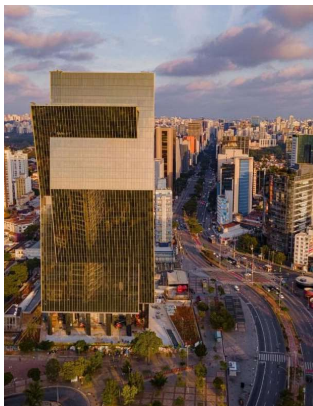
Fotos do Edifício FL Plaza
