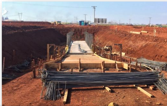
Armação do túnel da moega de carregamento
