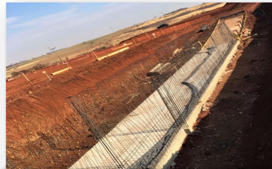
Armação do túnel da moega de carregamento
