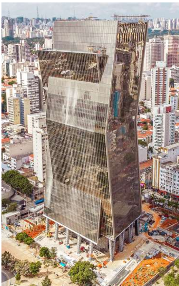
Foto da obra em andamento
