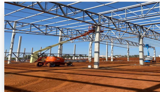
Montagem de Estruturas Metálicas
