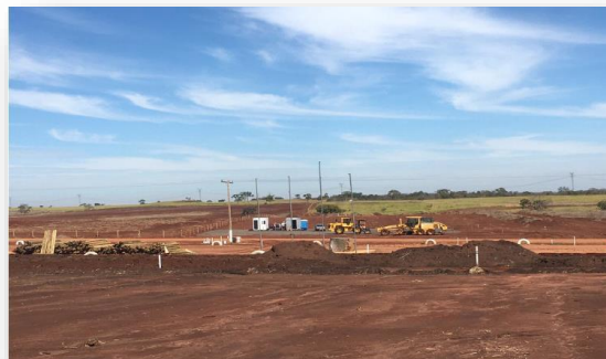
Mobilização do Canteiro de Obra
