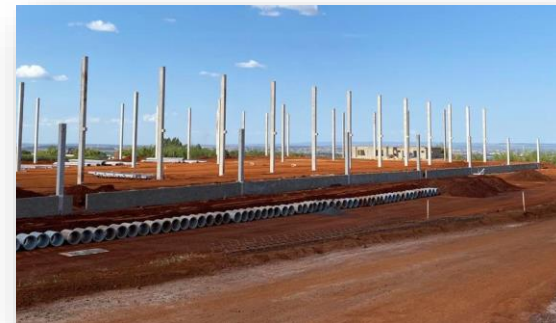
Execução do Muro de Arrimo as Docas
