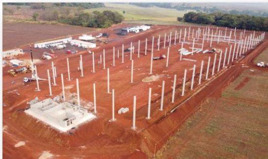
Montagem de Pilares
