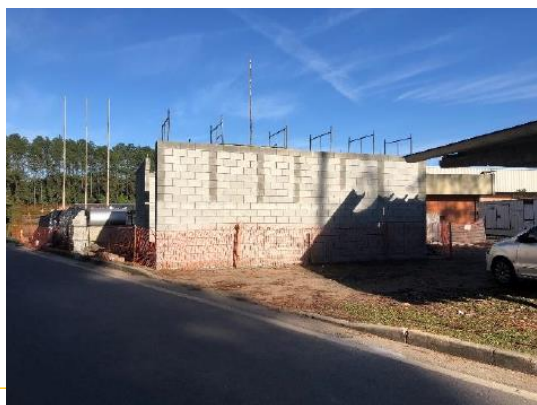
CONSTRUÇÃO DA NOVA SALA DO GERADOR
