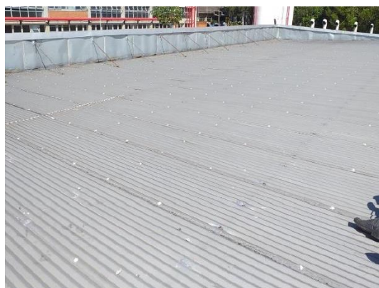
FINALIZAÇÃO DAS ÁREAS DE COBERTURA
