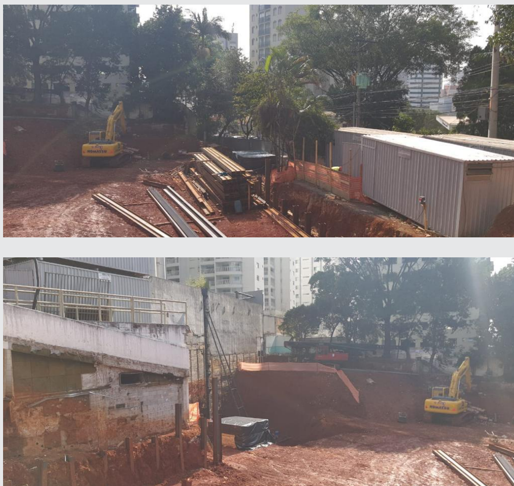
Fotos relacionados a obra da segunda fase: Andamento do processo de escavação e cravação das estacas da segunda fase
