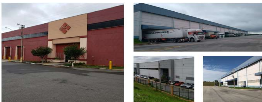
Barão de Mauá Atibaia / Jarinú, SP Rod Dom Pedro I, km 87,5, Ponte Alta Área Construída: 59.212 m 2 Participação: 100% Pé-direito (m): 9,6-10,0 Capacidade do Piso (ton/m 2 ): 5
