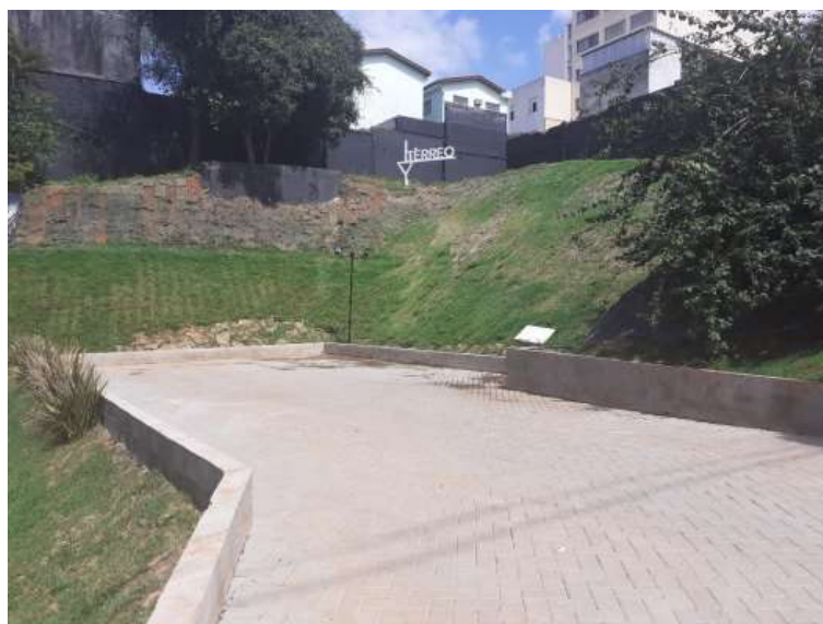
Vista interna do imóvel
