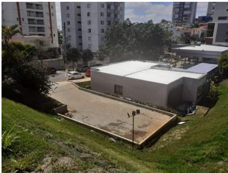
Vista interna do imóvel
