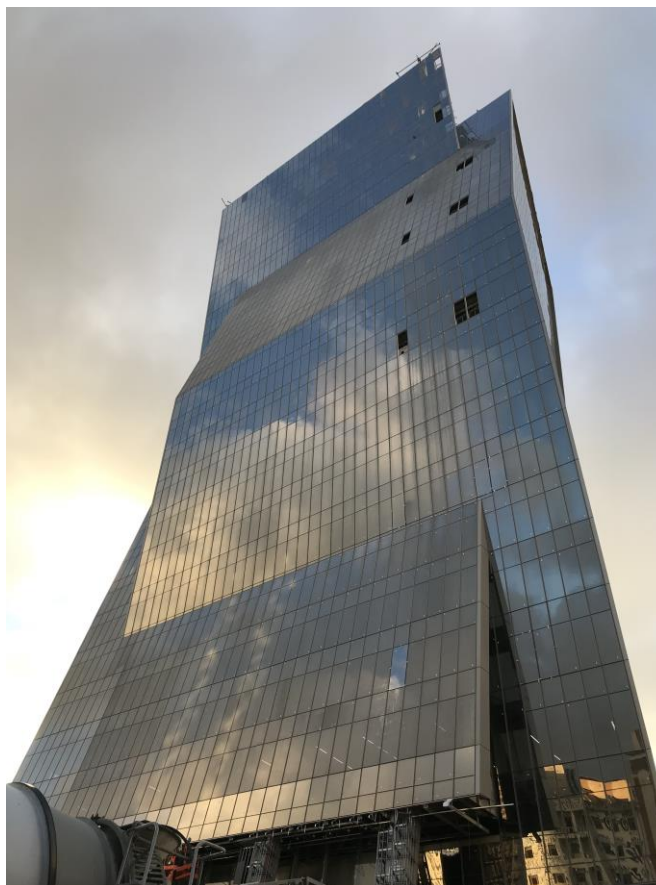
Fotos da obra em andamento
