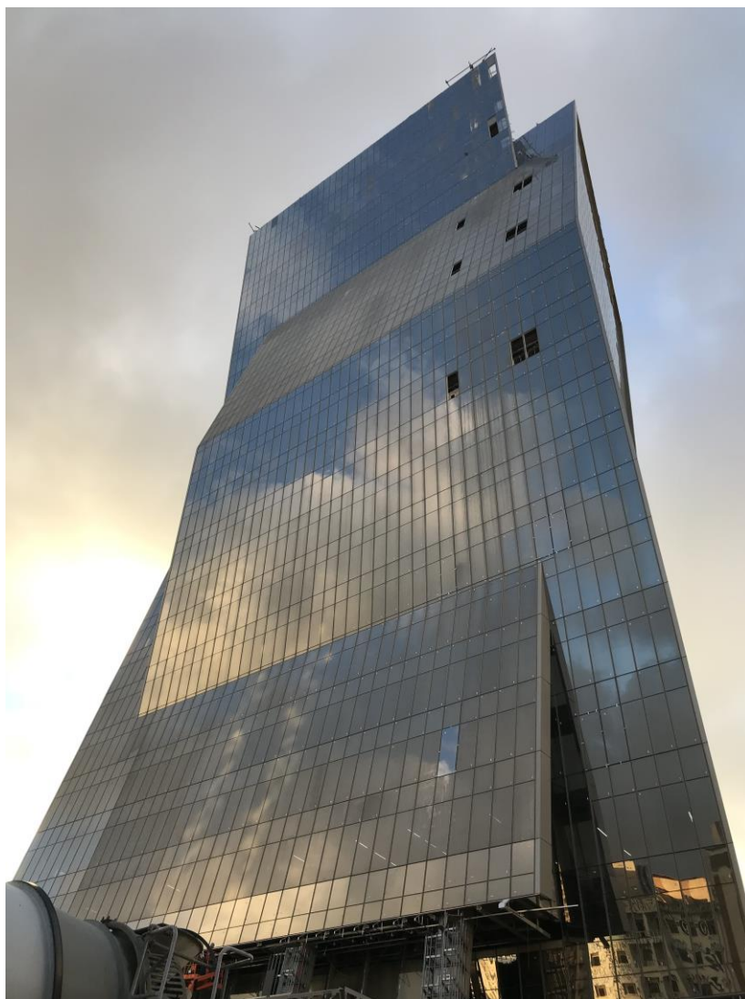
Foto da obra em andamento
