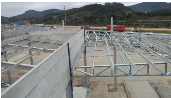
Execução de estrutura para cobertura do estacionamento
