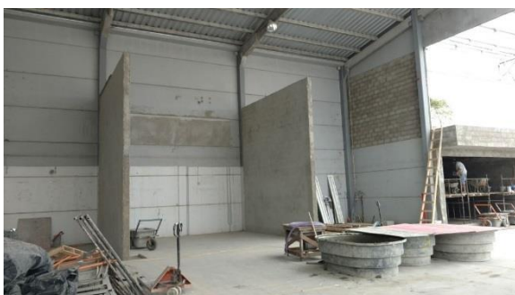
Execução de alvenarias divisórias para sanitários e áreas administrativas
