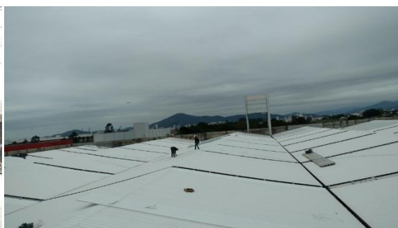
Execução de isolamento termo acústico em cobertura existente
