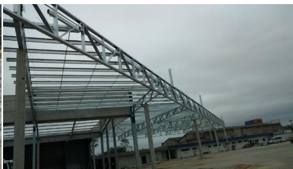
Execução de estrutura para cobertura do estacionamento
