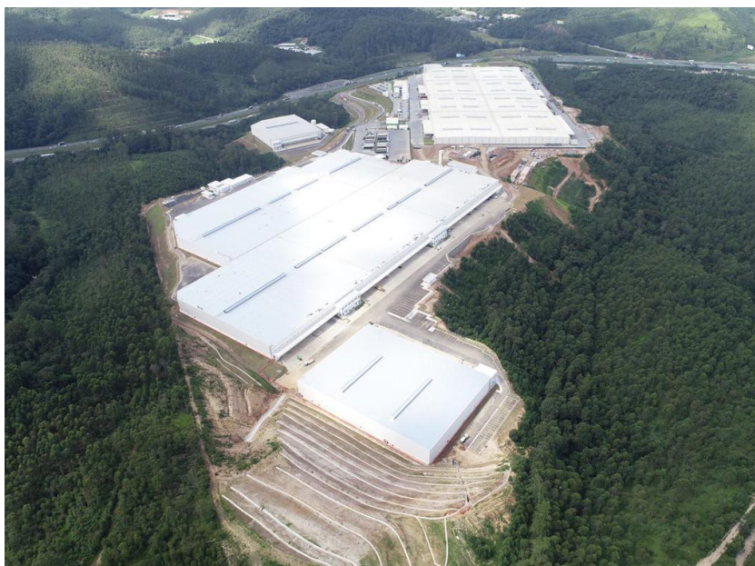
Execução de obras – Foto Panorâmica
