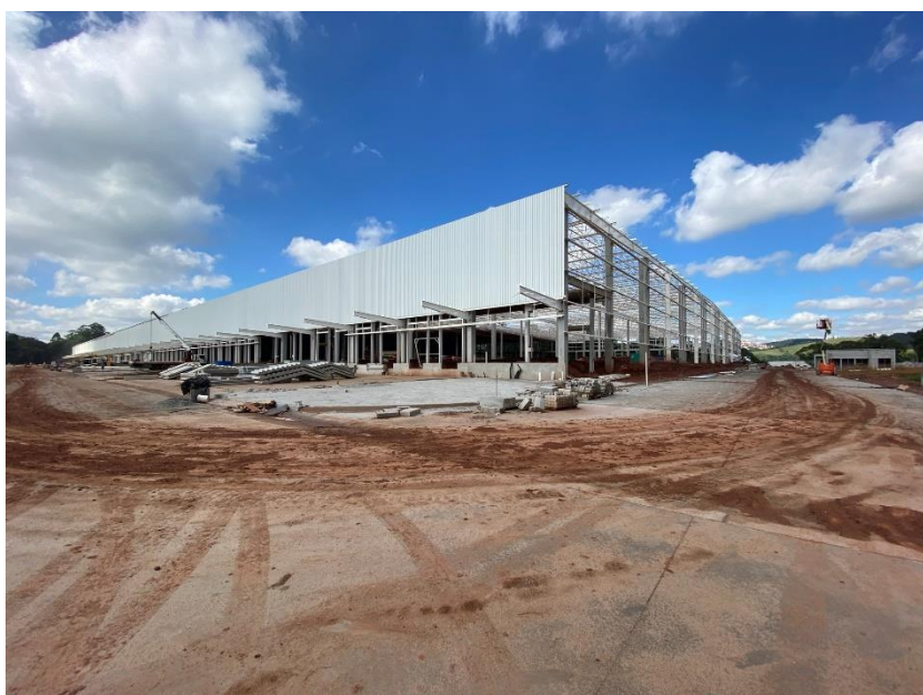
Execução de obras – Foto Panorâmica
