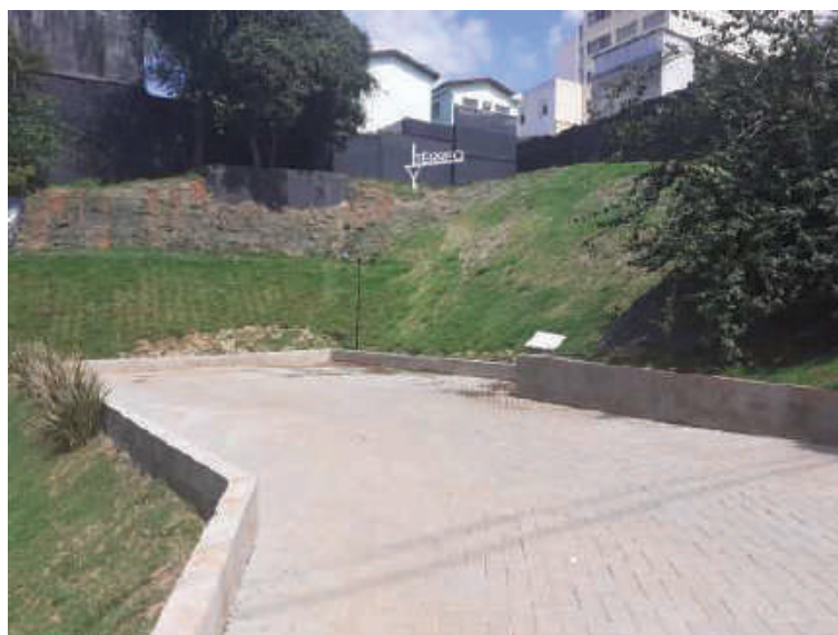
Vista interna do imóvel
