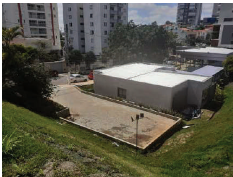
Vista interna do imóvel
