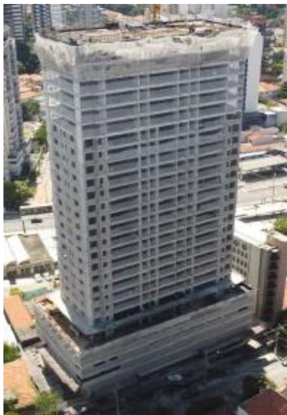
Foto Estrutura da Obra - Misce
