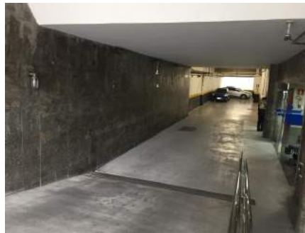
SUBSOLO – RAMPA DE ACESSO
