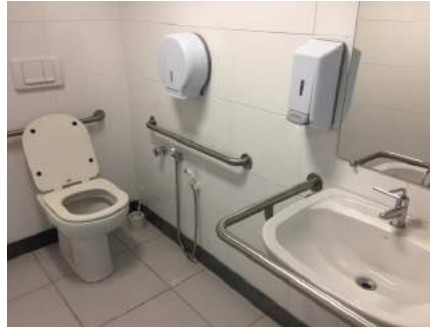
1º PAV (ANEXO) – SANITÁRIO
