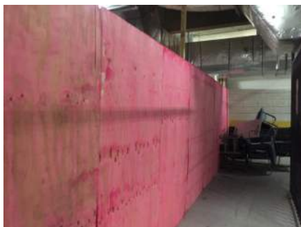
SUBSOLO – FOTOS INTERNAS
