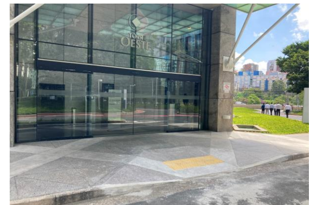
Nova rampa de acessibilidade
