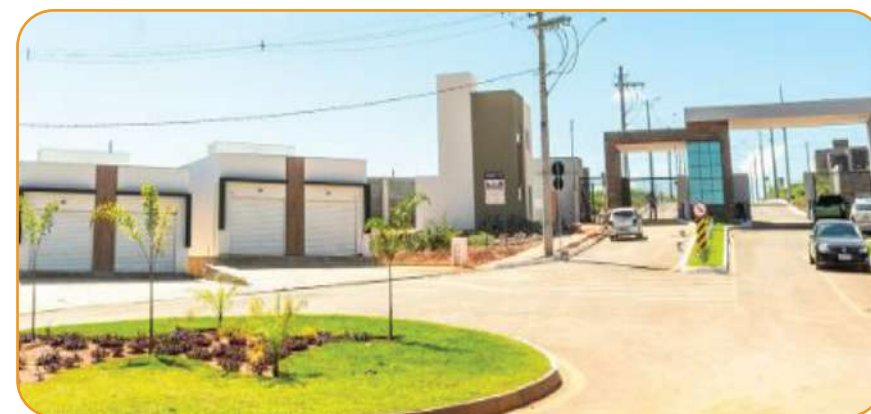
Entrada do empreendimento
