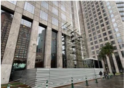
Revisão da fachada
