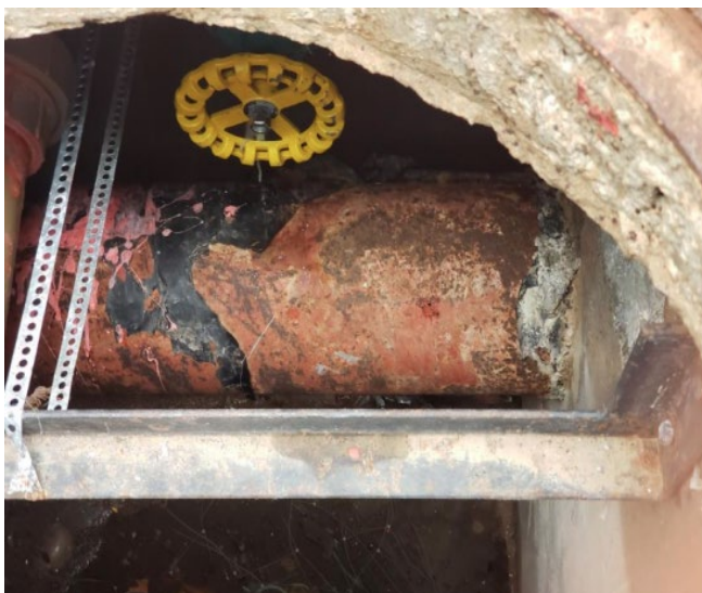
Rede principal de incêndio substituída.
