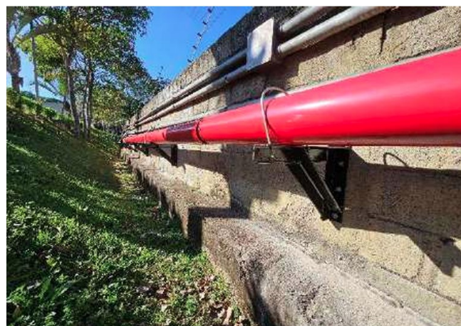
Nova rede de abastecimento de incêndio.
