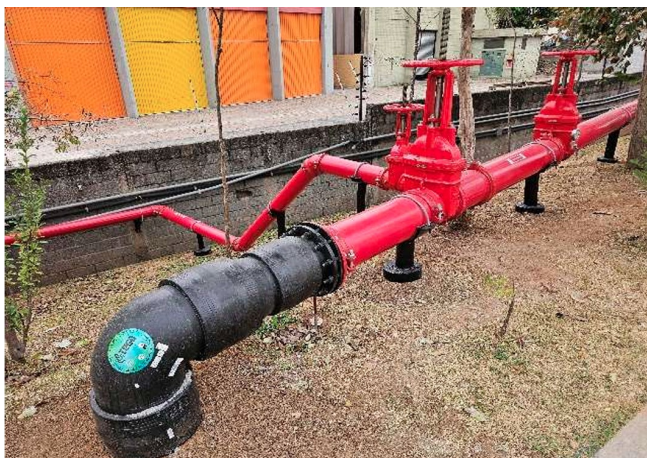
Nova rede de abastecimento de incêndio.
