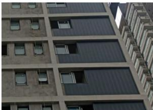
INSTALAÇÃO DO MINIWAVE FACHADA
