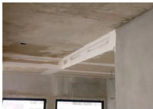
FORRO DE GESSO 10º PAVIMENTO
