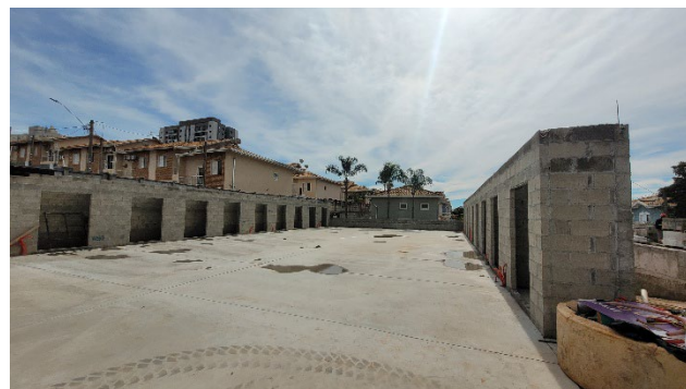
Bloco Garagem (mai/26) – Preparação para camada de impermeabilização.
