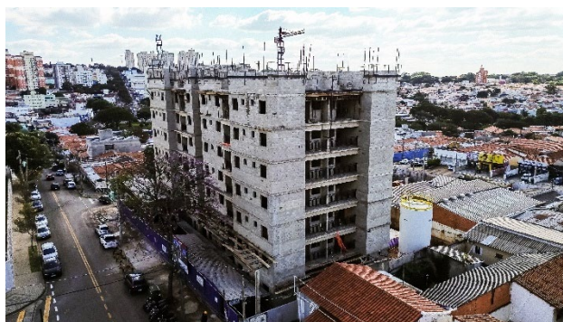
Imagem Aérea – Visão Geral (jun/26) – Execução da alvenaria estrutural do 7º pavimento da torre residencial.
