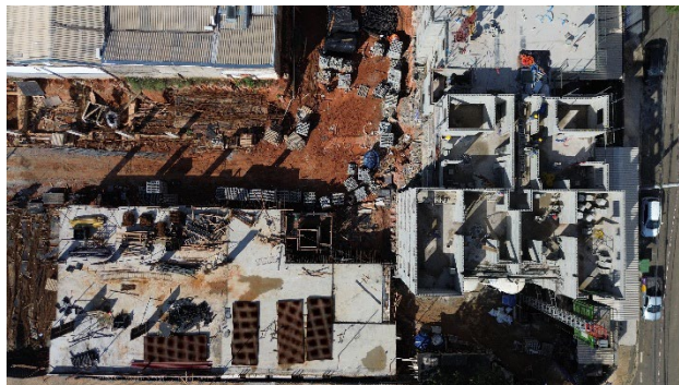
Imagem Aérea – Visão Geral (abr/26) – Execução da laje do 3º pavimento do edifício residencial e 1º pavimento do bloco garagem.
