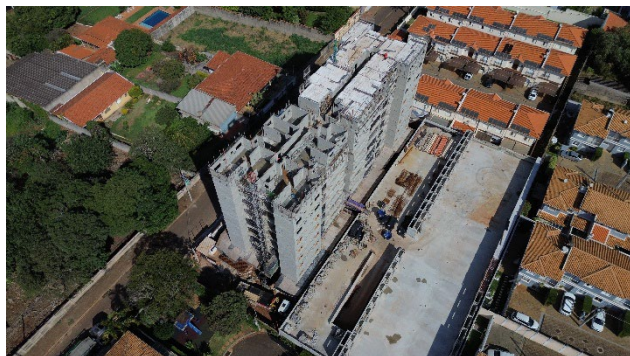
Imagem Aérea – Visão Geral (abr/26) – Execução da alvenaria estrutural do 8º pavimento.
