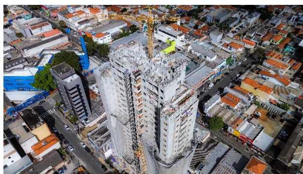
Imagem Aérea – Visão Geral (jun/26) – Execução da alvenaria estrutural do 26º pavimento.
