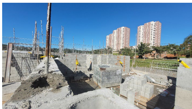
Torre residencial B (jun/26) – Execução de alvenaria estrutural do 1º pavimento.
