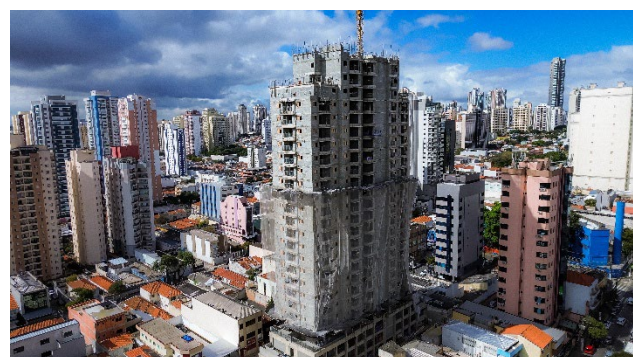
Imagem Aérea – Visão Geral (jun/26) – Execução da alvenaria estrutural do 26º pavimento.
