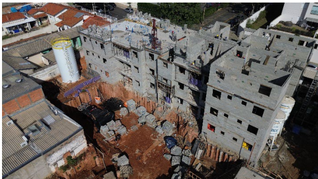
Imagem Aérea – Visão Geral (abr/26) – Execução da laje do 3º pavimento do edifício residencial e 1º pavimento do bloco garagem.
