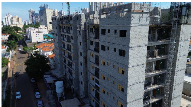
Imagem Aérea – Visão Geral (abr/26) – Execução da alvenaria estrutural do 8º pavimento.
