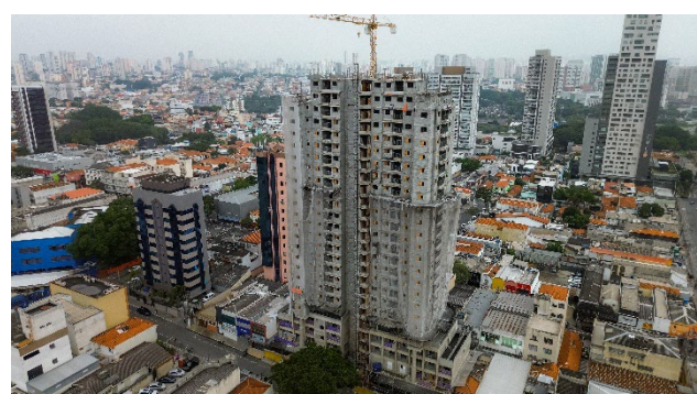
Imagem Aérea – Visão Geral (mai/26) – Estrutura no 24º pavimento.
