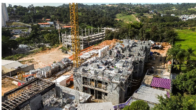
Imagem Aérea – Visão Geral (jun/26) – Execução da alvenaria estrutural do 3º pavimento da torre residencial B.
