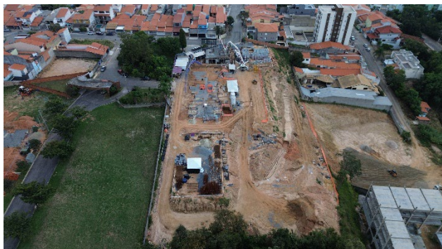
Imagem Aérea – Visão Geral (abr/26) – Concretagem parcial da área de lazer.
