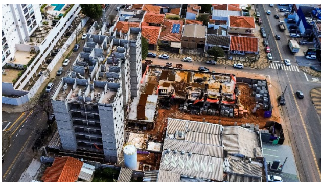
Imagem Aérea – Visão Geral (jun/26) – Execução da alvenaria estrutural do 7º pavimento da torre residencial.
