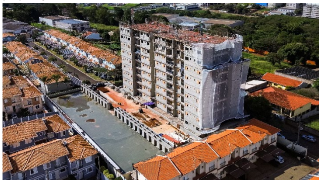
Imagem Aérea – Visão Geral (jun/26) – Preparação para concretagem do 10º pavimento.
