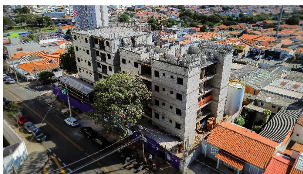
Imagem Aérea – Visão Geral (mai/26) – Execução da alvenaria estrutural do 5º pavimento da torre residencial.
