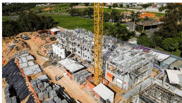
Imagem Aérea – Visão Geral (jun/26) – Execução da alvenaria estrutural do 3º pavimento da torre residencial B.
