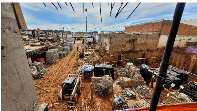
Bloco Garagem (mai/26) – Execução dos pilares e organização do canteiro para avanço da laje do Bloco Garagem.
