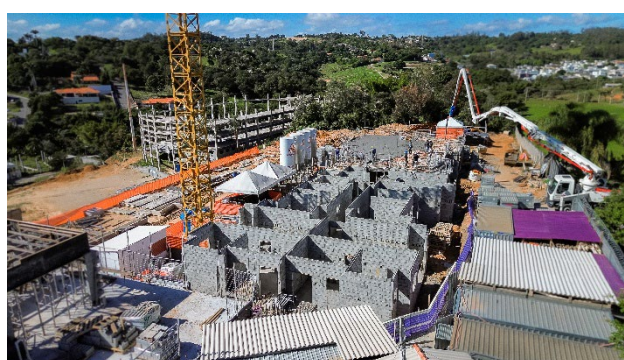
Imagem Aérea – Visão Geral (mai/26) – Execução da concretagem do 1º pavimento da torre residencial B.
