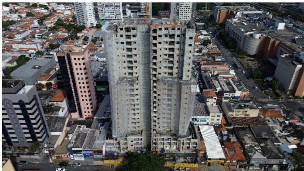
Imagem Aérea – Visão Geral (abr/26) – Estrutura no 23º pavimento.
