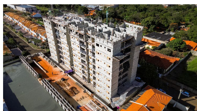
Imagem Aérea – Visão Geral (mai/26) – Execução da alvenaria estrutural do 9º pavimento.
