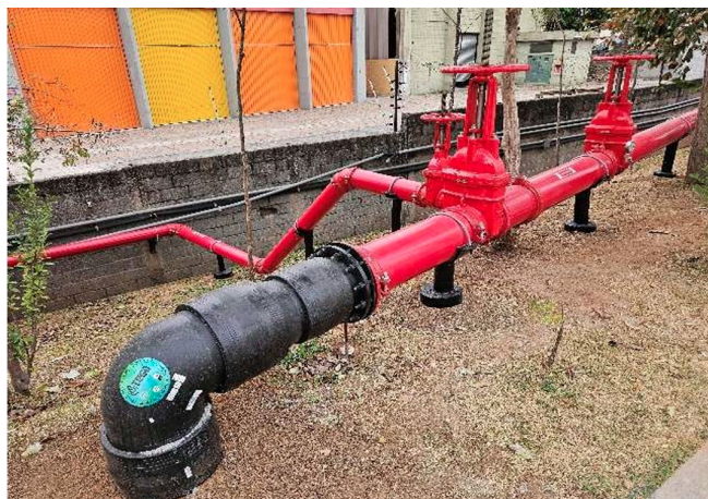
Nova rede de abastecimento de incêndio.
