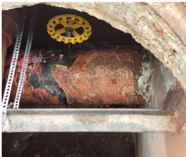
Rede principal de incêndio substituída.
