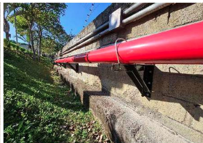
Nova rede de abastecimento de incêndio.
