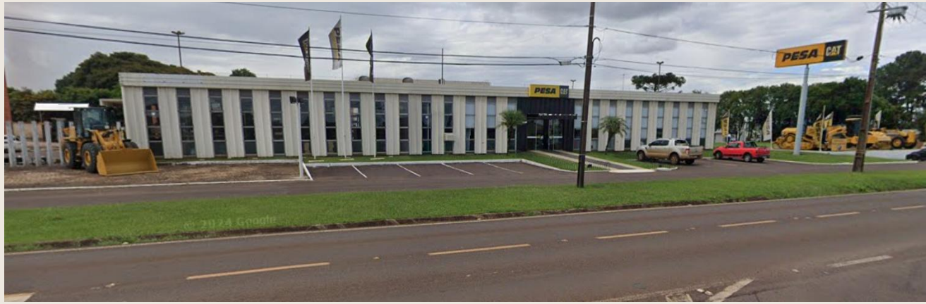
Concessionária Paraná Equipamentos, localizada na Rodovia BR-277, Km 589, Maria Luiza, Cascavel - PR.
