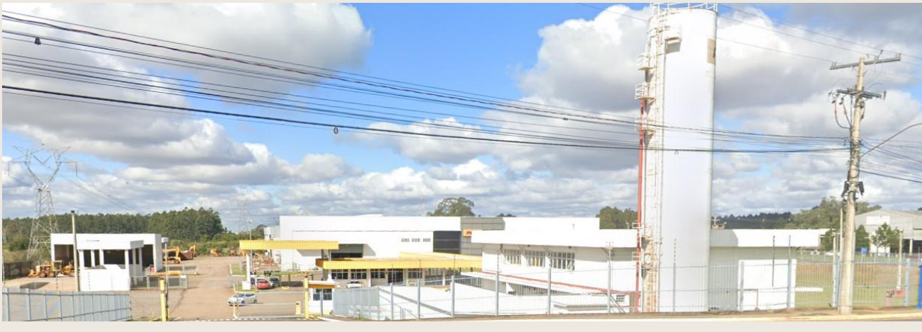
Concessionária Paraná Equipamentos, localizada na Rodovia BR-386, nº 3.960, Floresta, Nova Santa Rita – RS.
