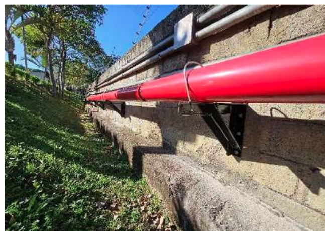
Nova rede de abastecimento de incêndio.
