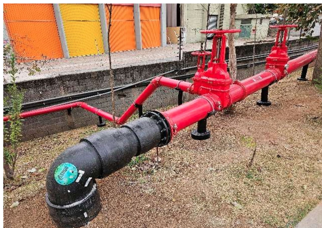
Nova rede de abastecimento de incêndio.
