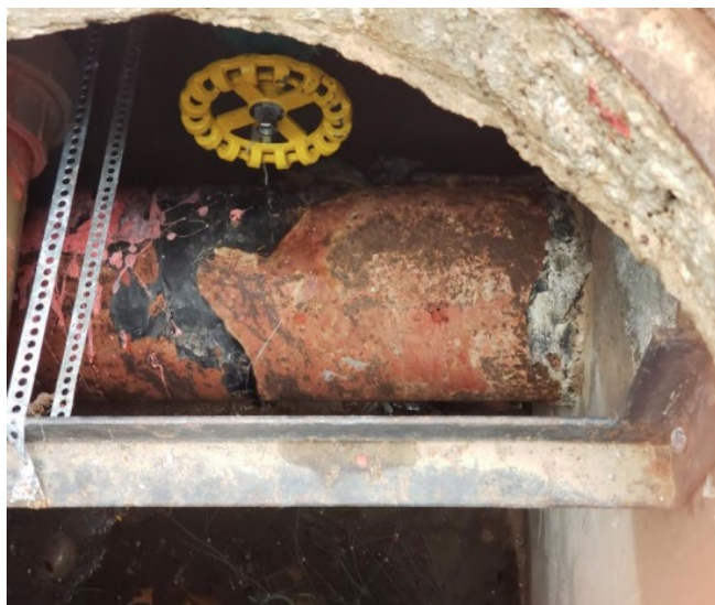
Rede principal de incêndio substituída.
