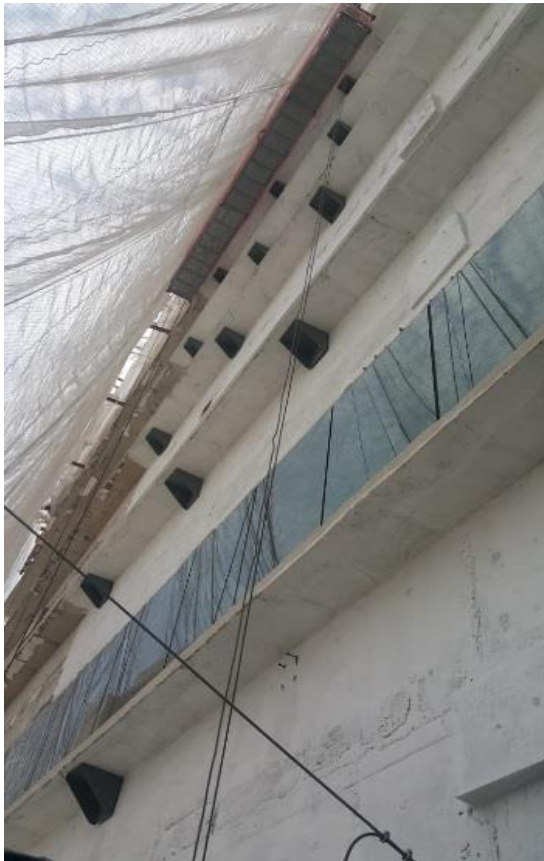
Tratamento e impermeabilização da estrutura da fachada
