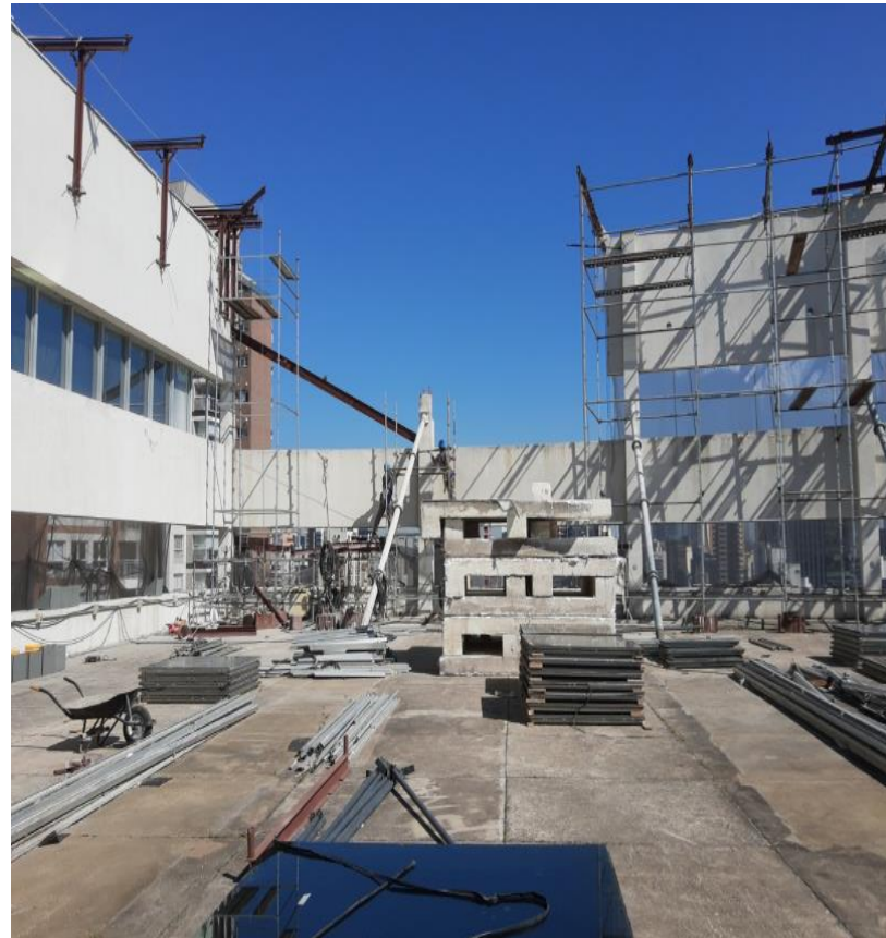
Restituição da Viga da Cobertura
