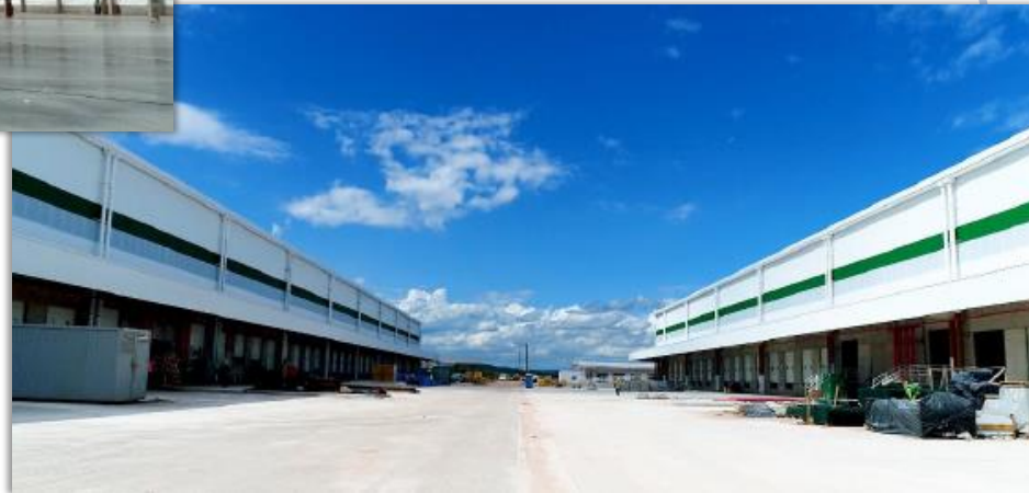
Área de carga e descarga
