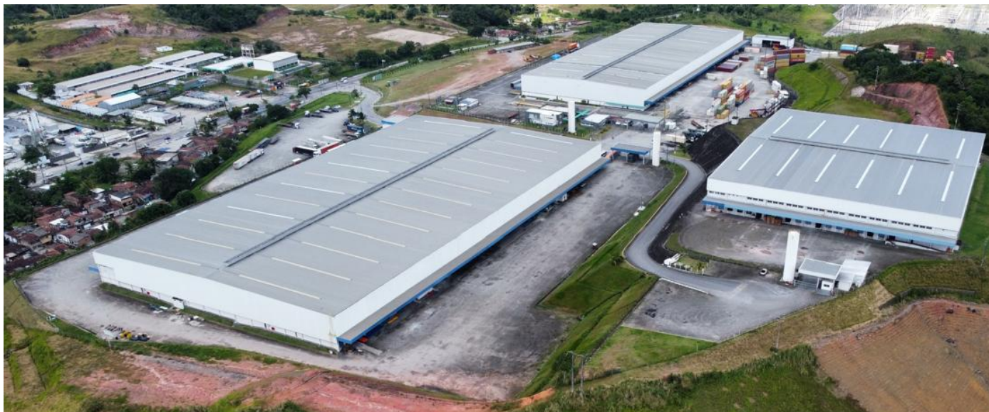
Imagem 3: Foto Aérea dos Galpões
