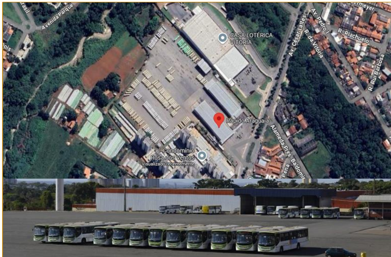
Garagem Oeste, Rápido Araguaia Ltda., localizado na Avenida Presidente JK, 260, Jardim Presidente – Goiânia – GO.
