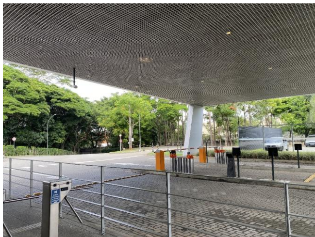
ACESSO DE VEÍCULOS
