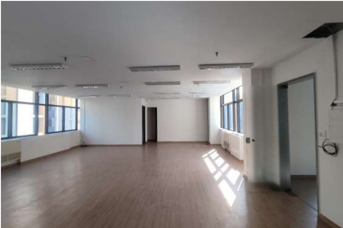
Conjunto 91 – situação atual
