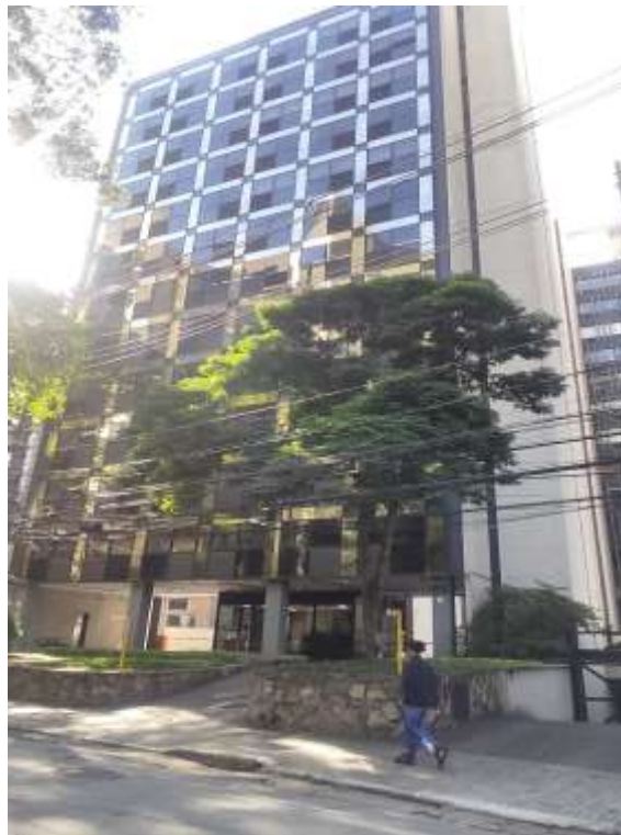
Fachada do Edifício
