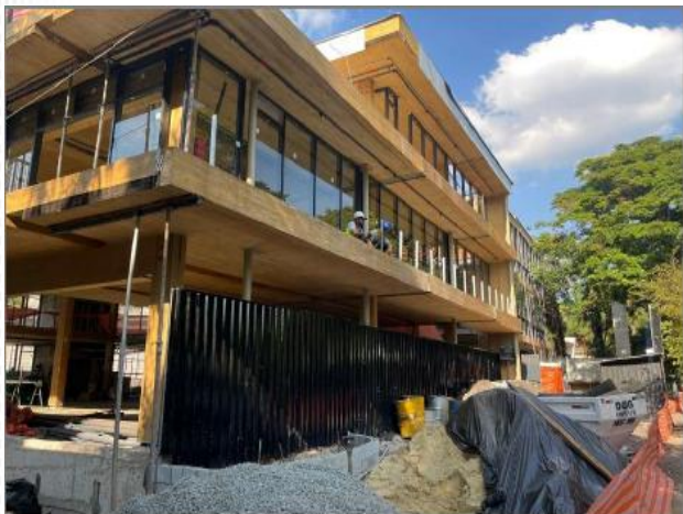
Fachada frontal com caixilhos e SPK
