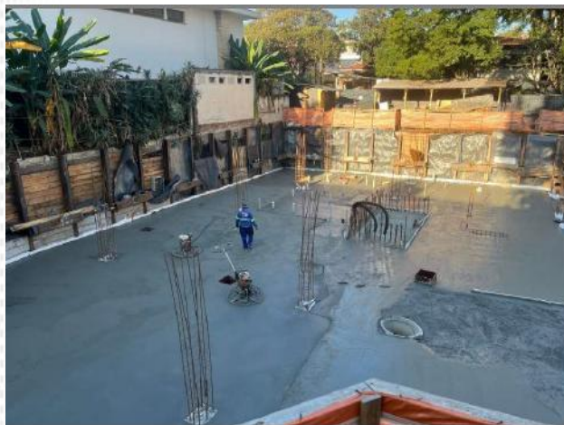
Concretagem de piso – Torre Ferreira
