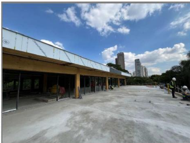
ACM da cobertura
