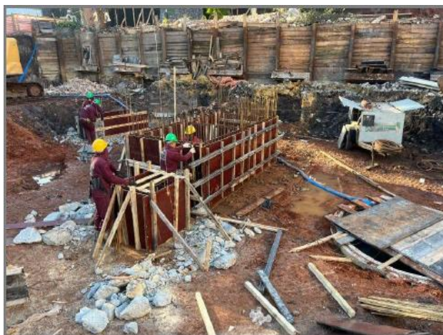
Forma do poço do elevador – Torre Pedroso
