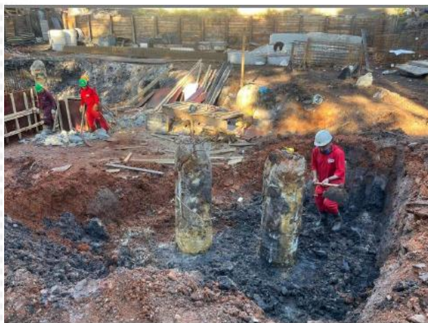
Arrasamento de estaca - Torre Pedroso
