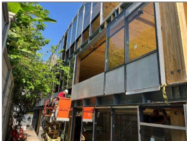
Execução de placas cimentícias da fachada
