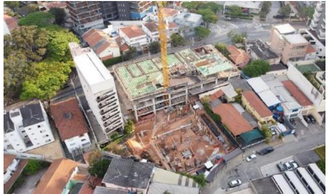
Foto da Escavação e Estrutura da Obra
