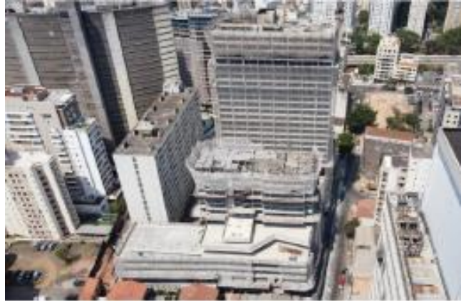
Foto Estrutura da Obra
