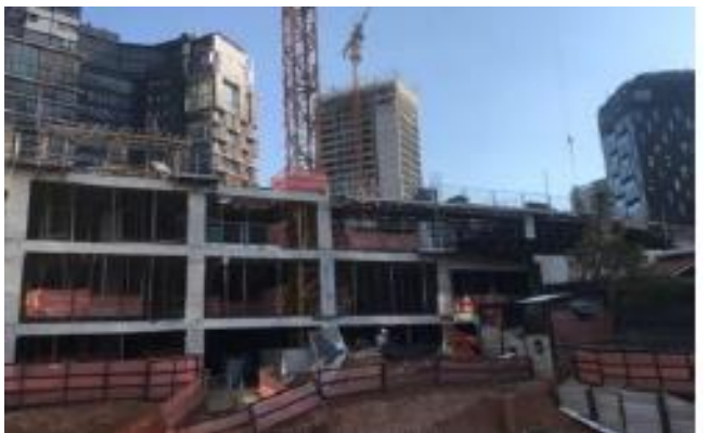
Foto Estrutura da Obra
