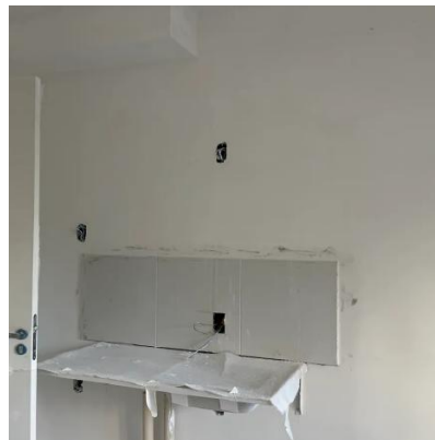
Vista interna unidade
