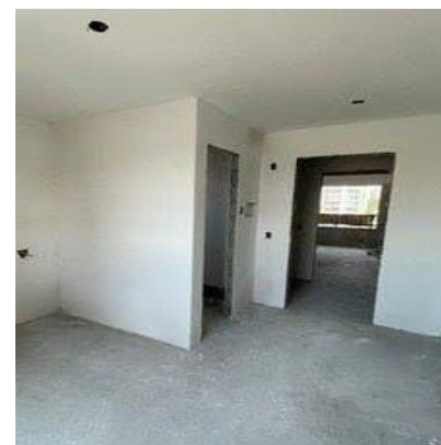
Vista interna unidade
