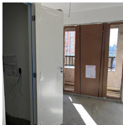
Vista interna unidade
