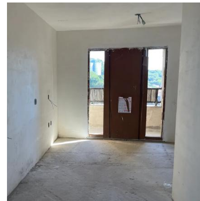
Vista interna unidade
