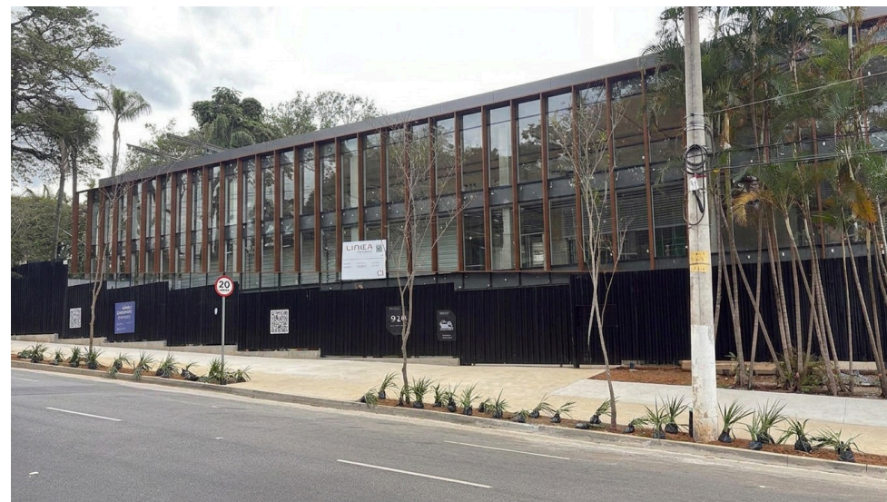
FOTO DA OBRA
