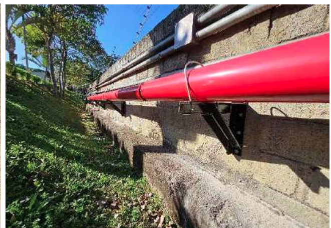
Nova rede de abastecimento de incêndio.
