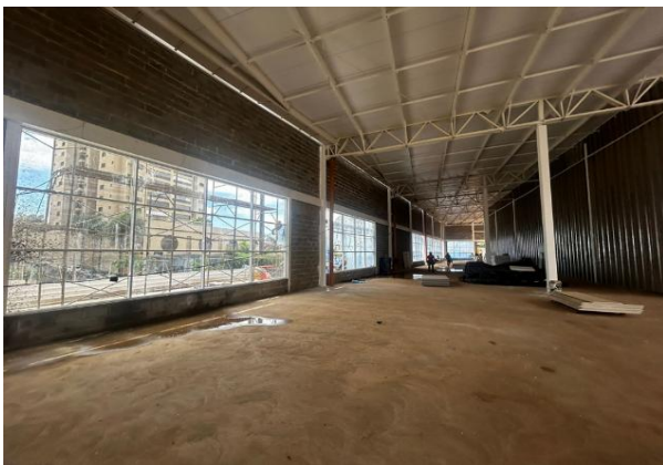
Expansão: Em andamento concretagem piso. Fonte: Alqia e HSI
