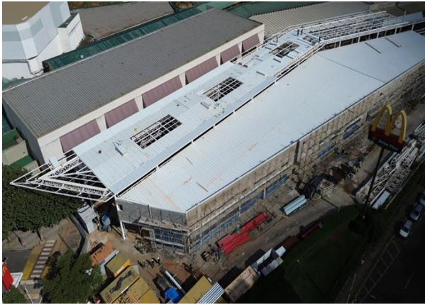
Expansão: Em andamento alvenaria e cobertura. Fonte: Alqia e HSI
