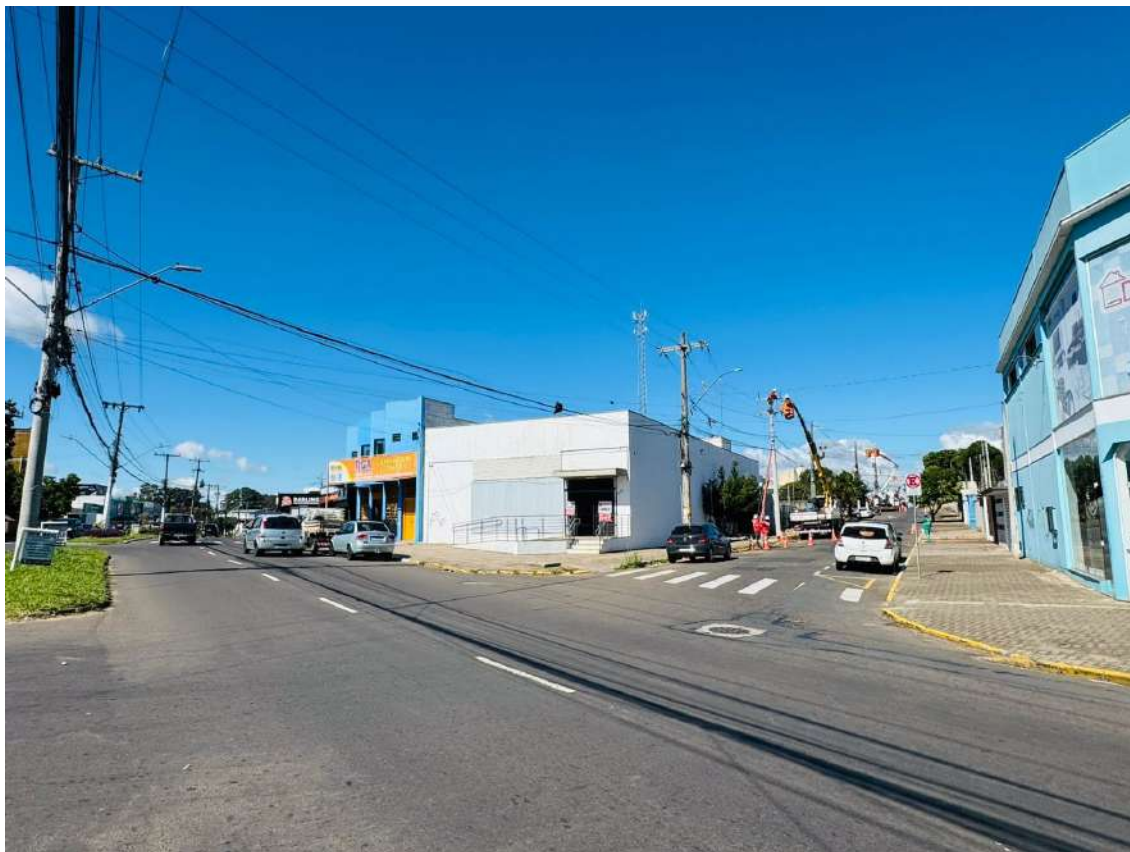
Vista do Imóvel - Fonte: BRCC
