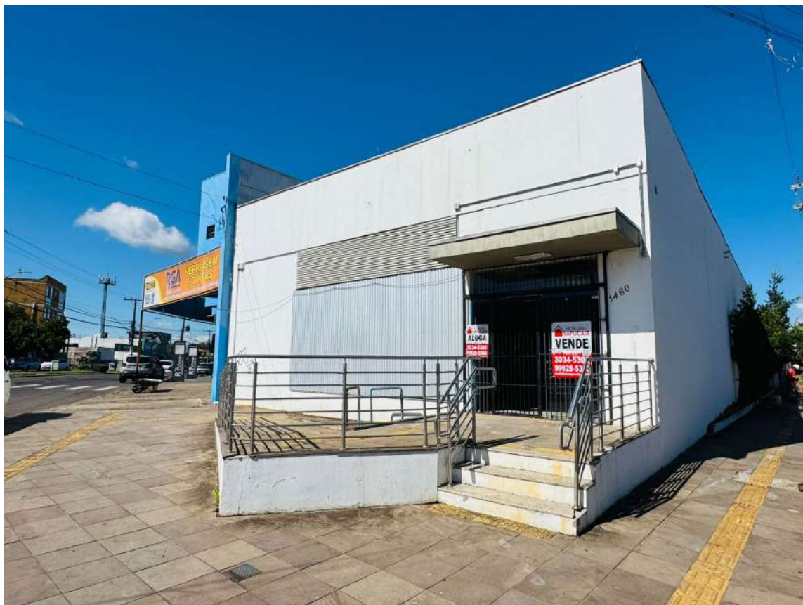
Vista do Imóvel - Fonte: BRCC
