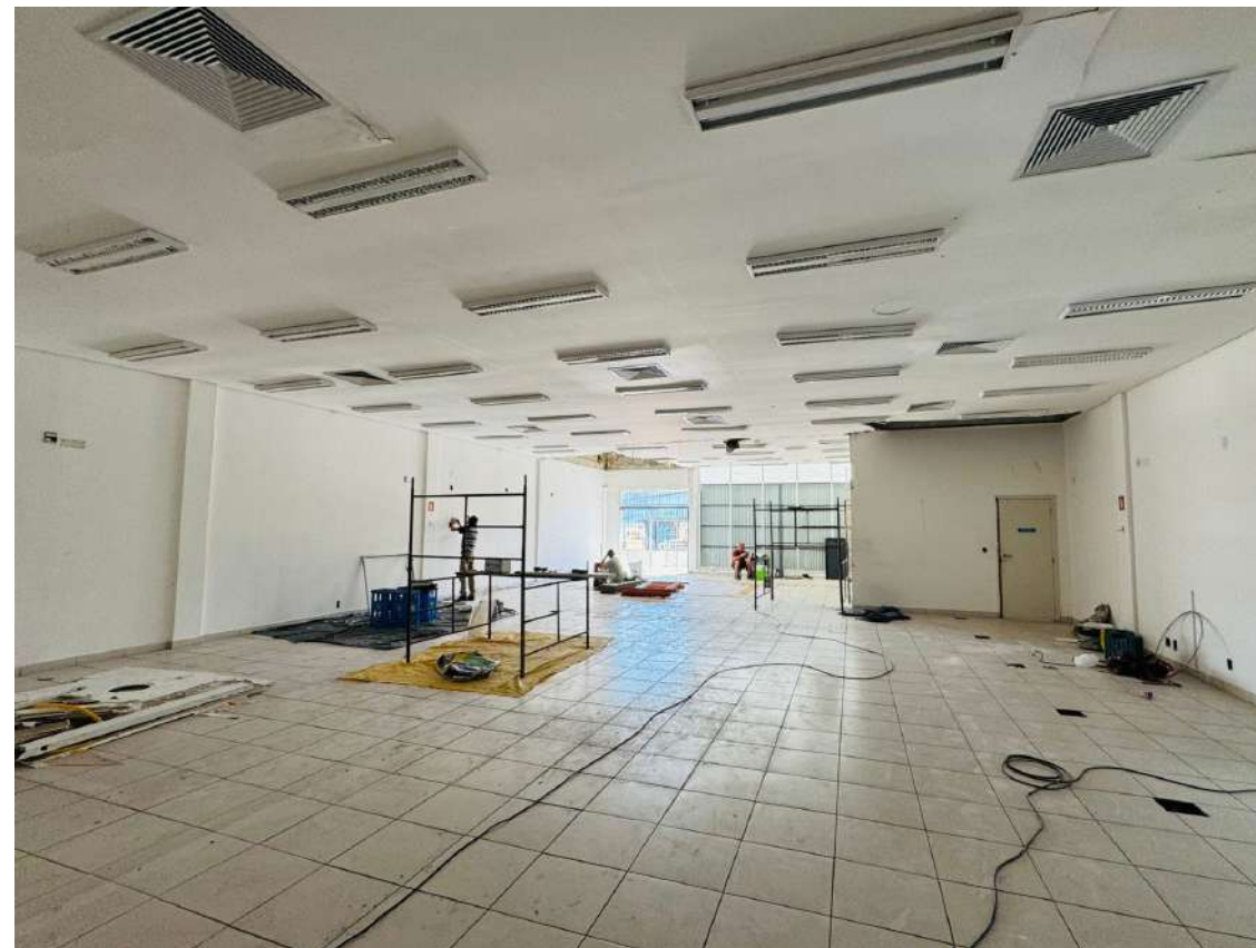
Vista do Imóvel - Fonte: BRCC
