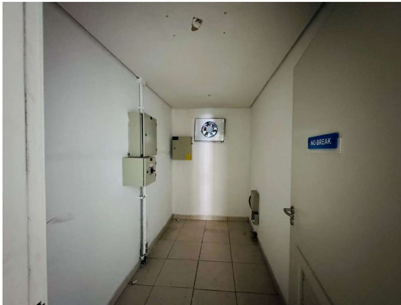
Vista do Imóvel - Fonte: BRCC
