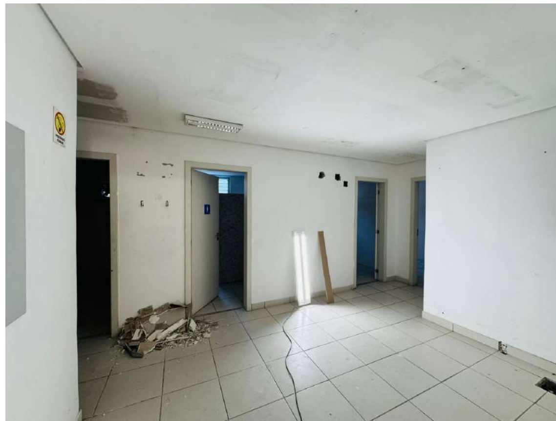
Vista do Imóvel - Fonte: BRCC
