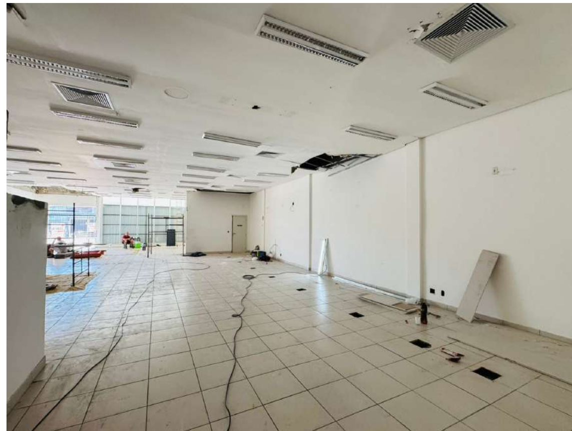
Vista do Imóvel - Fonte: BRCC
