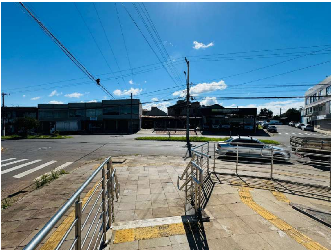
Vista do Imóvel - Fonte: BRCC
