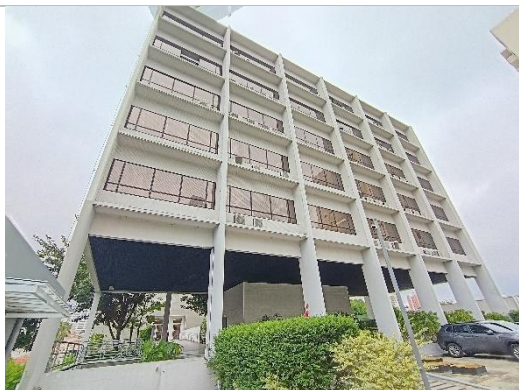
Fachada lateral do imóvel
