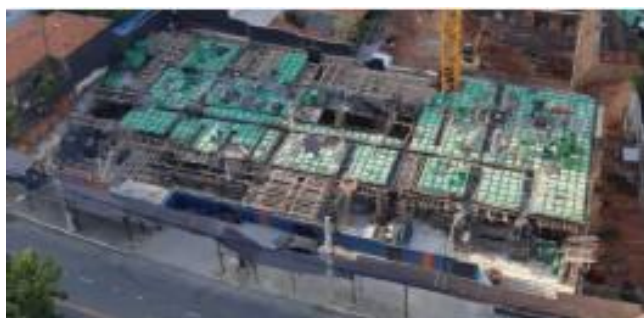
Foto Estrutura da Obra
