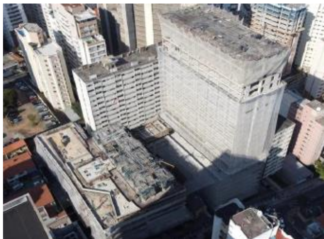
Foto Estrutura da Obra
