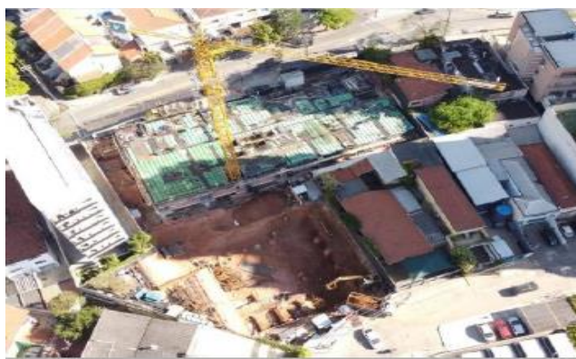
Foto da Escavação da Obra
