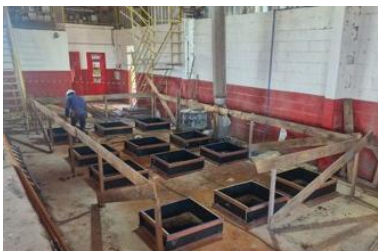
Obras civis para instalação de máquinas de pré-limpeza
