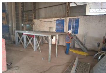
Montagem de máquinas de pré-limpeza
