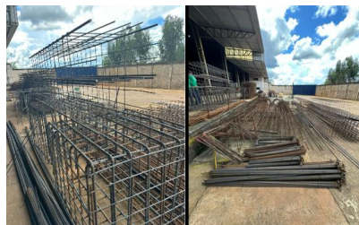
Avanços em ferragens para instalação do novo tombador
