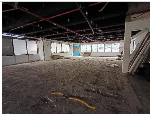
Andar em processo de retrofit
