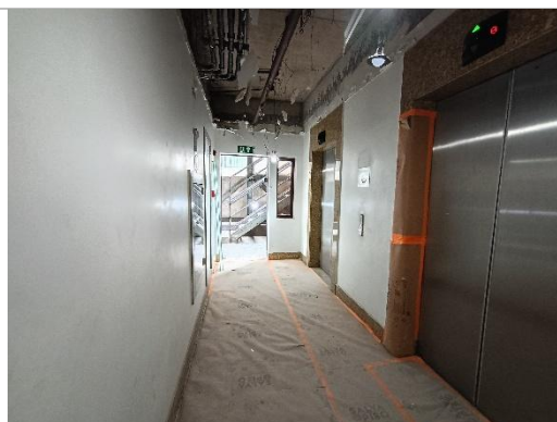
Andar em processo de retrofit
