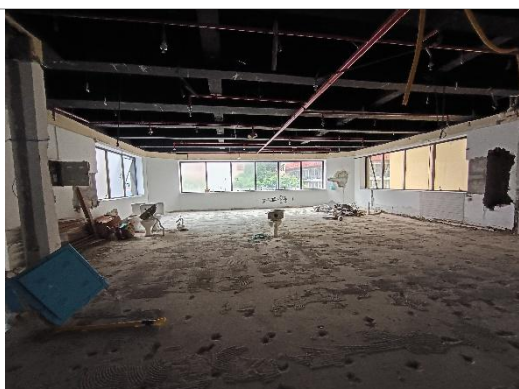
Andar em processo de retrofit
