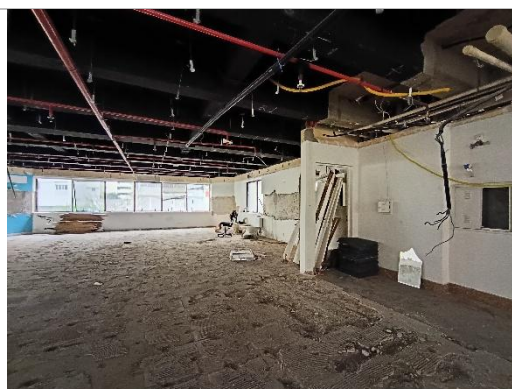
Andar em processo de retrofit
