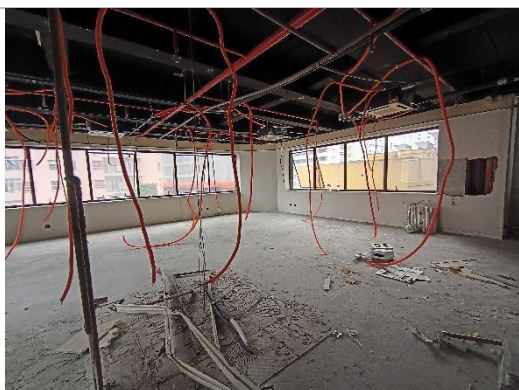
Andar em processo de retrofit
