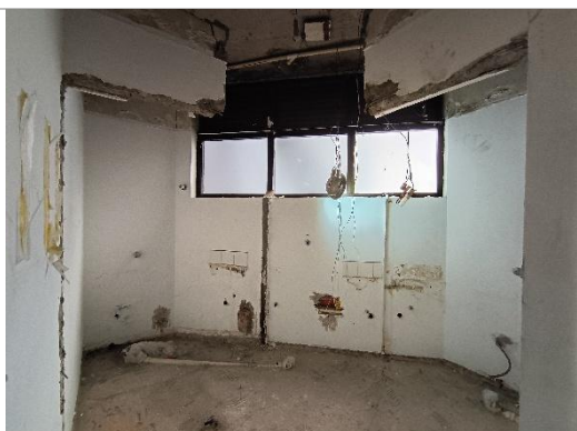
Andar em processo de retrofit
