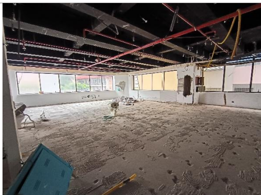
Andar em processo de retrofit
