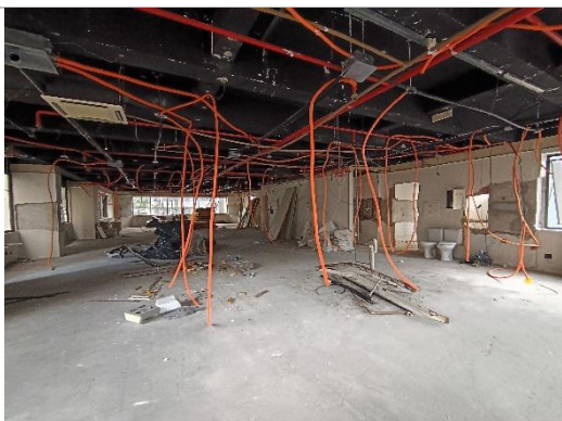
Andar em processo de retrofit
