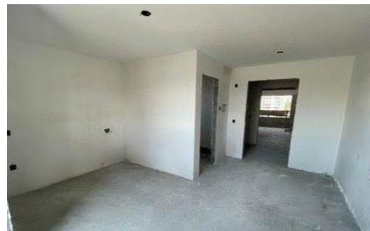
Acabamento gesso liso unidade
