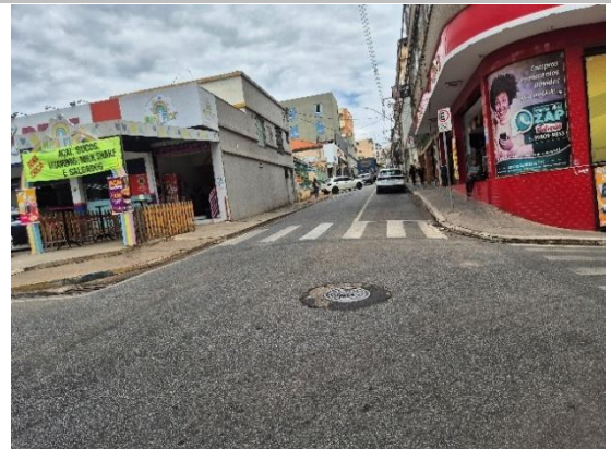
Rua Gonçalves da Guia
