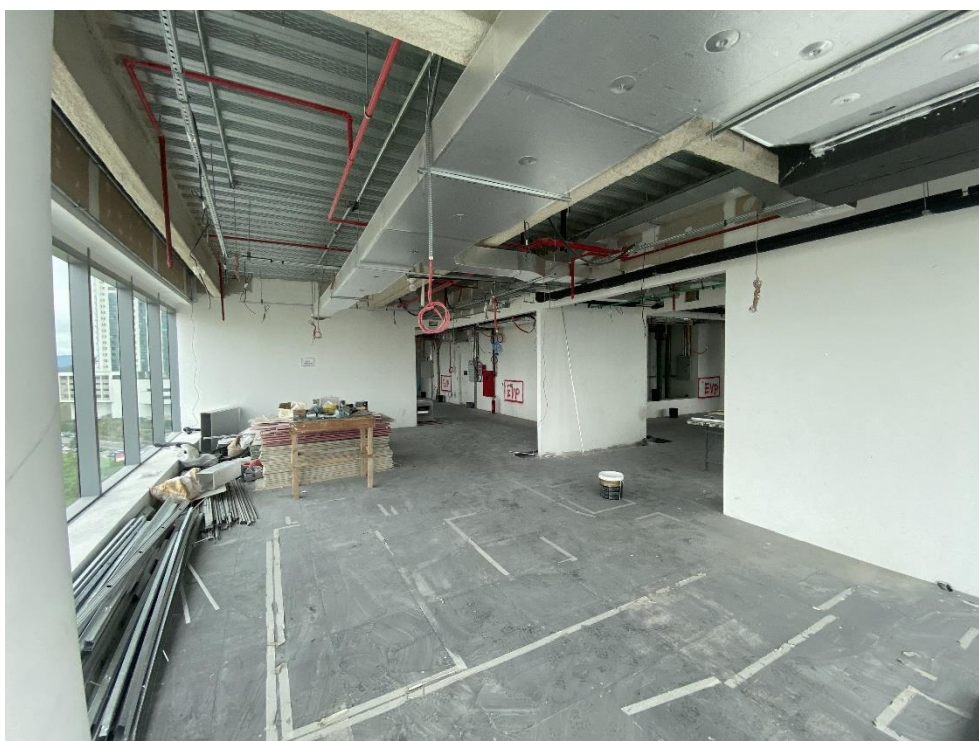
Vista interna do imóvel
