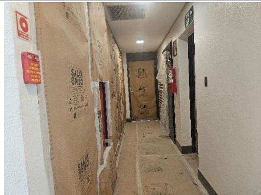
Hall 25º Pavto
