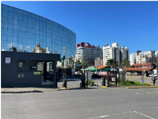
Fachada secundaria imóvel avaliando vista 01
