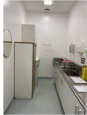
Sala de serviços
