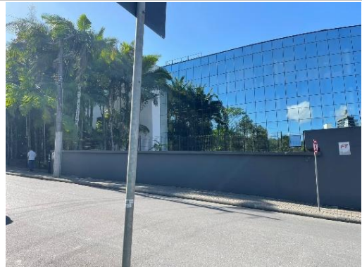
Fachada secundaria imóvel avaliando vista 02
